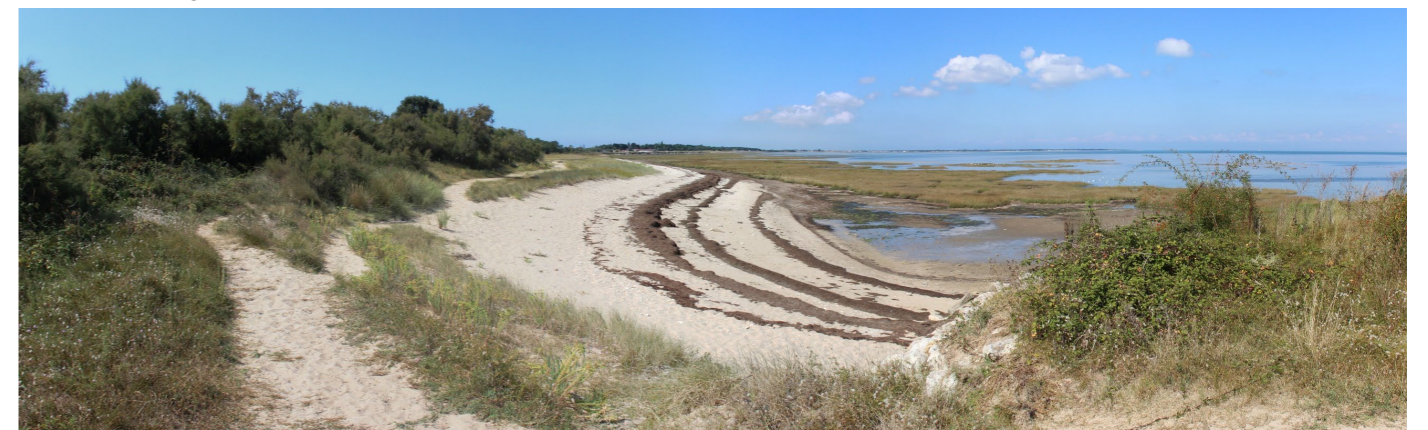
5 – Vue sur le sentier au nord de la pointe des Doux : Point dur du parcours lié à l'érosion générant un recul progressif du trait de côte et une adaptation du tracé du sentier.
