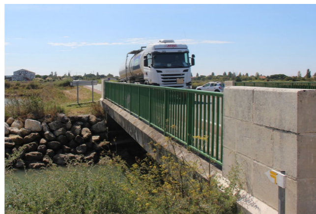
Tronçon en accotement de la RD734 au niveau du Chenal D'Oulme (franchissement sur le pont routier) (Source : Atelier du périscope)
