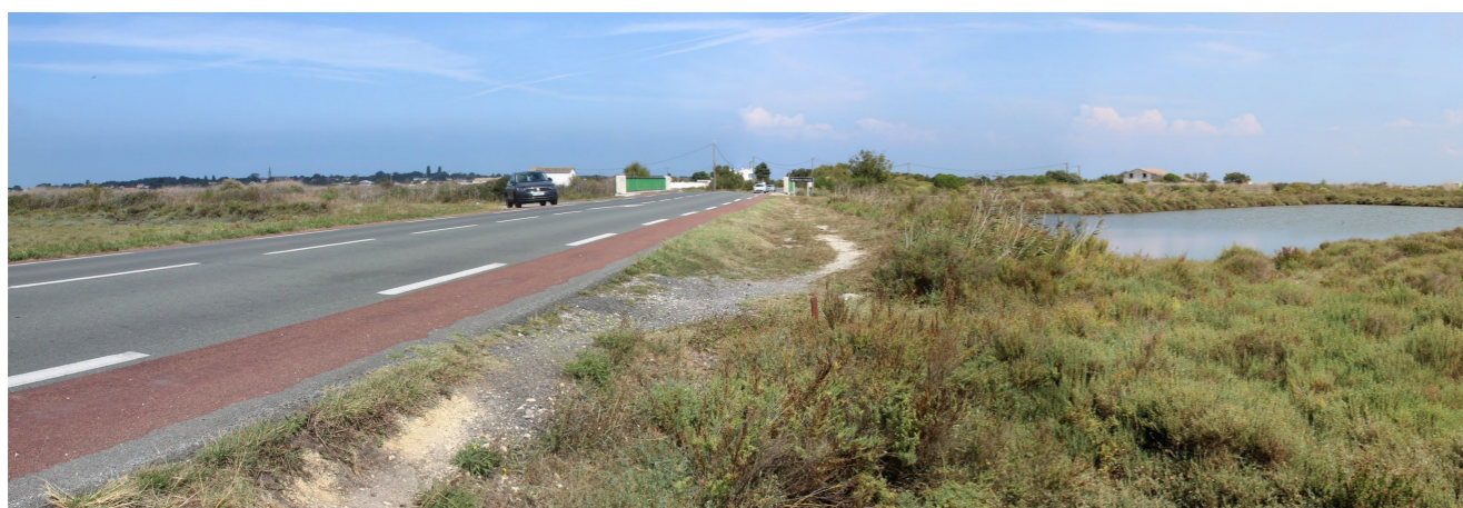
24 – Vue sur le sentier : Séquence en accotement de la RD734 en amont du franchissement du Canal d'Oulme
