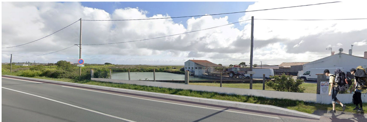
Figure 11 : Illustration du projet : bordure séparative en béton bouchardé en accotement de la RD 734
