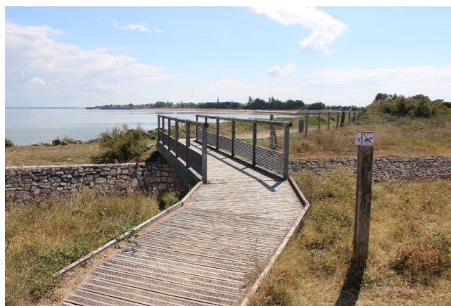
7 – Vue sur la passerelle de franchissement du chenal de l'Étier Neuf : Un ouvrage qui met en scène la vue sur la citadelle du Château
