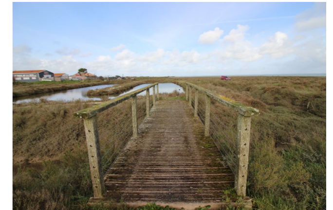
19 – Vue sur le sentier : passerelle de franchissement existante
