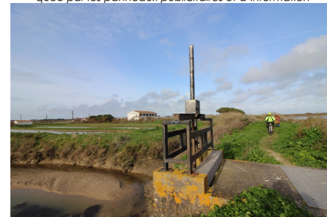
22 – Vue sur le sentier : Porte à flot permettant la gestion du niveau de l'eau dans le marais
