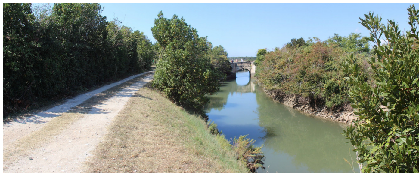
1 – Vue sur le Pont Napoléon depuis le sentier
