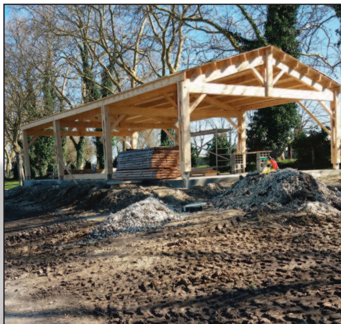
Avant les travaux & pendant les travaux
