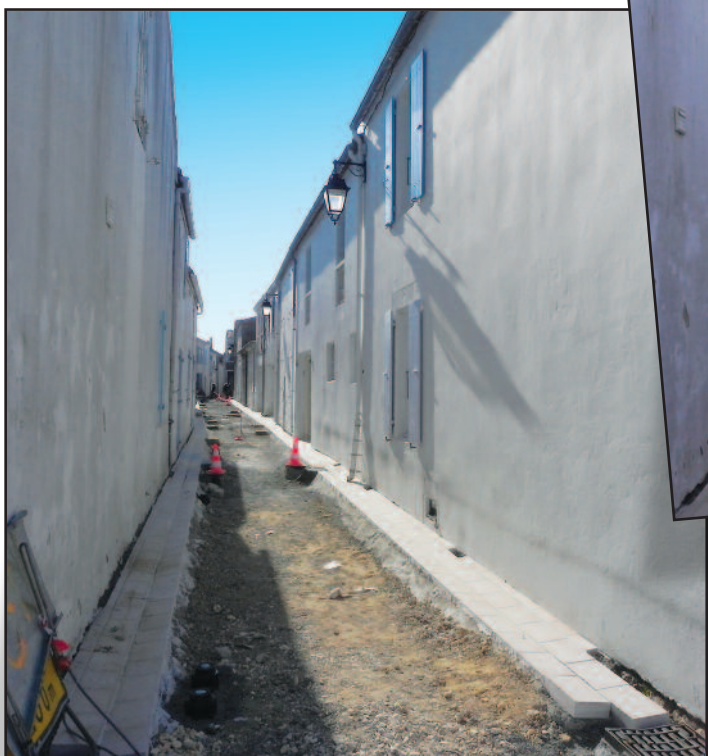
Pendant les travaux
