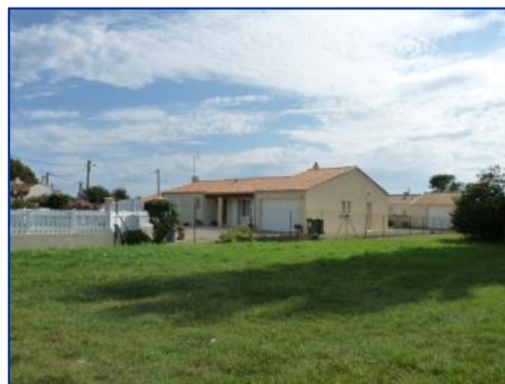
Construction pavillonnaire en milieu de parcelle
