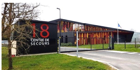
Nouveau bâtiment du SDIS rue de la distillerie
