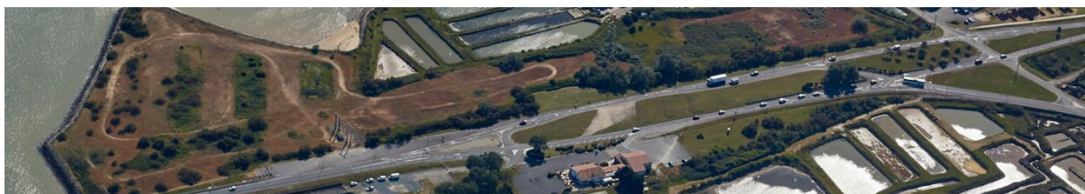
Voie et délaissés de voirie au sortir du Pont (à gauche)
