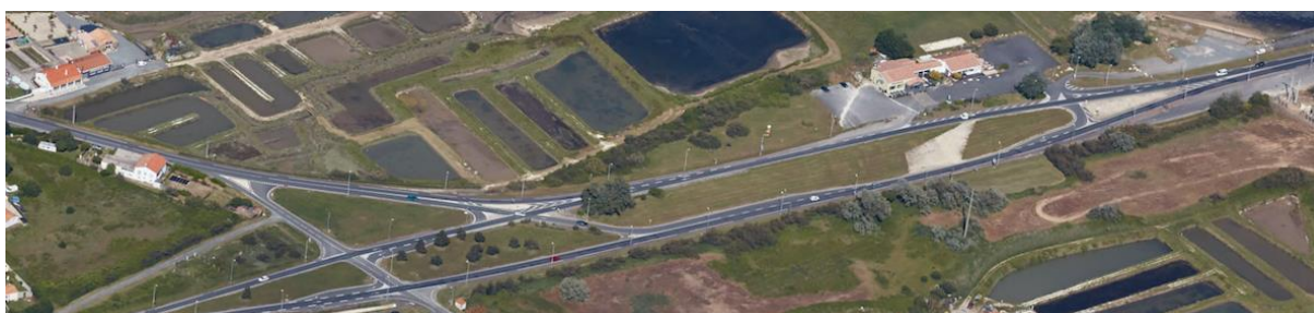
Voie et délaissés de voirie au sortir du Pont (pont à droite)
