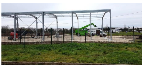
Bâtiments en construction sur la RD.26
