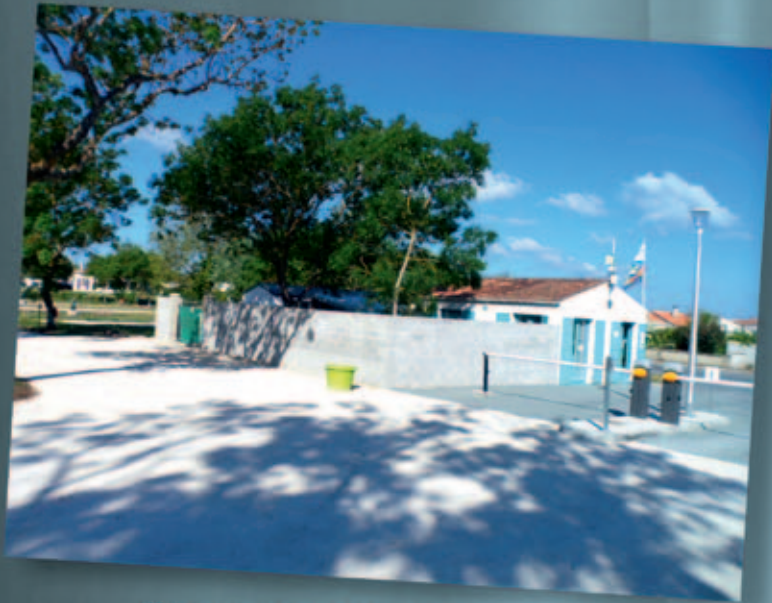
Travaux au camping
