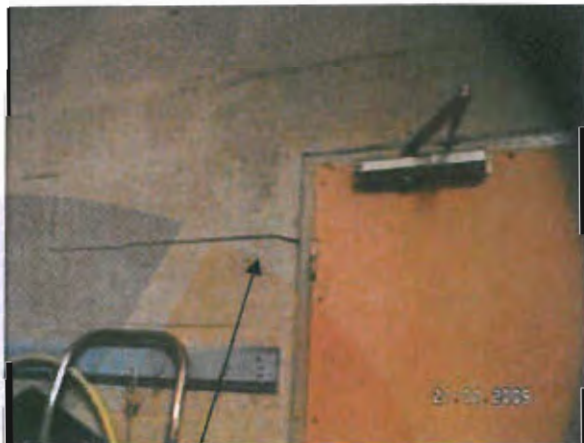
Fissure traversante
