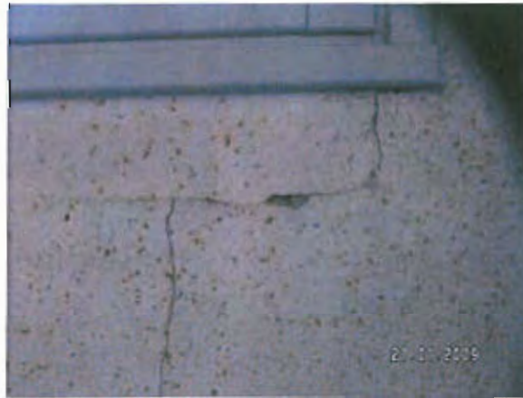
Vue de l'intérieur dans le couloir donnant côté rue. Au niveau de chaque poteau on trouve une fissure verticale descendant jusqu'au sol.
