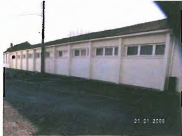
Vue côté rue de la partie à expertiser
