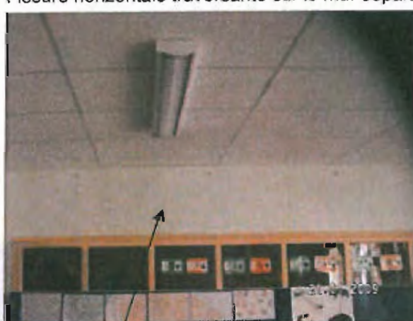
Fissure horizontale traversante sur le mur séparant les 2 classes
