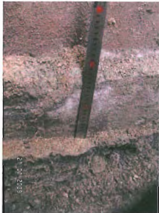
La semelle débord de 4cm et a une hauteur d'environ 16 cm sur un sous sol sablonneux. Sur ce type de sous sol déformable une semelle plus large aurait dut être mise en œuvre.
