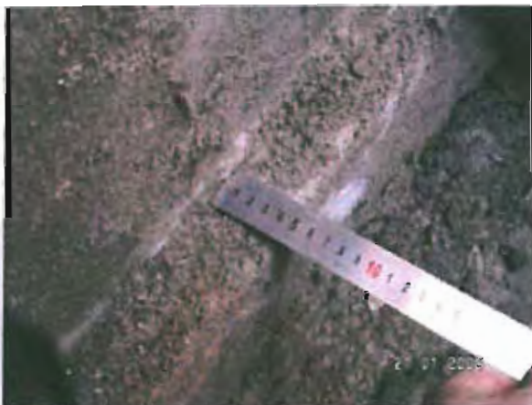
La semelle débord de 4cm et a une hauteur d'environ 16 cm sur un sous sol sablonneux. Sur ce type de sous sol déformable une semelle plus large aurait dut être mise en œuvre.
