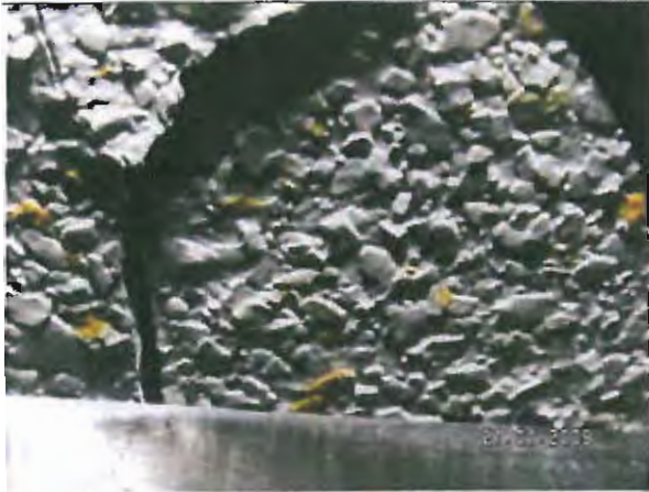
Désaffleurement des lèvres de la lézarde et
