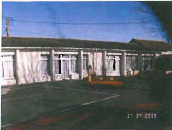
Vue côté cour de la partie à expertiser Tranchée
