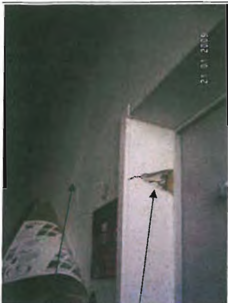
Fissure verticale avec désaffleurement, éclat de l'enduit
