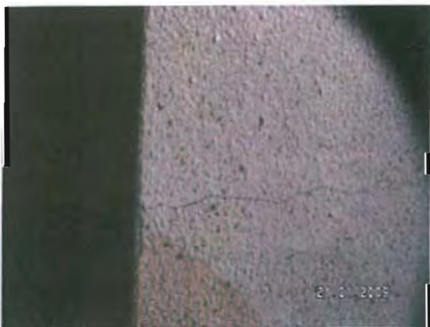
Fissure horizontale traversante au niveau de la baie séparant les 2 classes, fissure verticale
