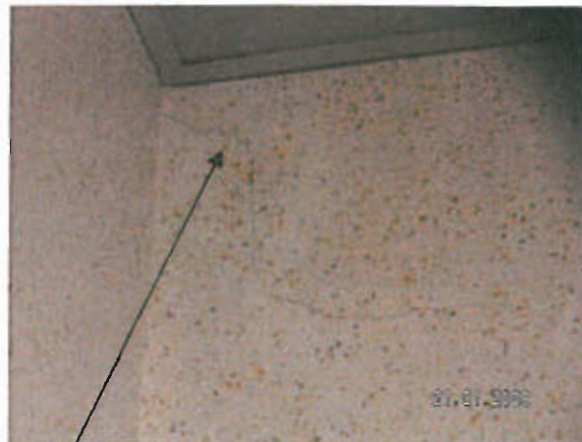
Au début du couloir dans le mur de séparation des classes et des locaux techniques, plusieurs fissures, une horizontale traversante en haut à droite de la porte, une en biais sur le mur de la porte et au coin de l'angle rentrant, une horizontale en pied de mur.
