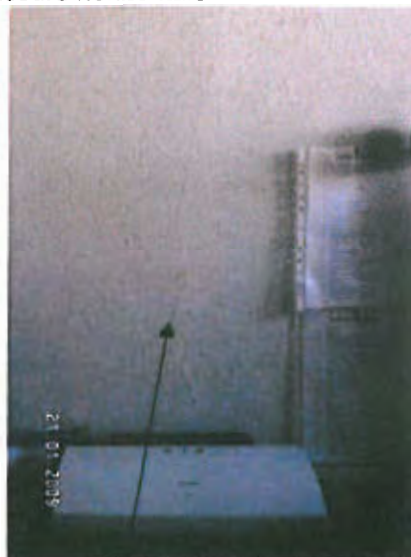
Fissure horizontale traversante au niveau de la baie séparant les 2 classes, fissure verticale
