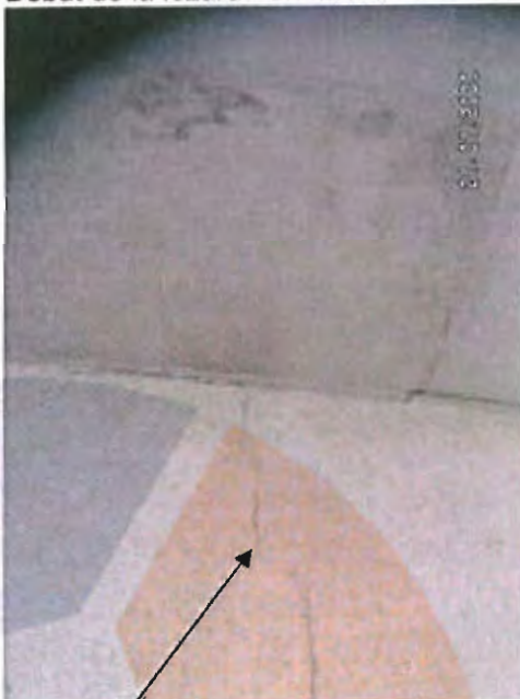
Fissures verticales sur le mur mitoyen
