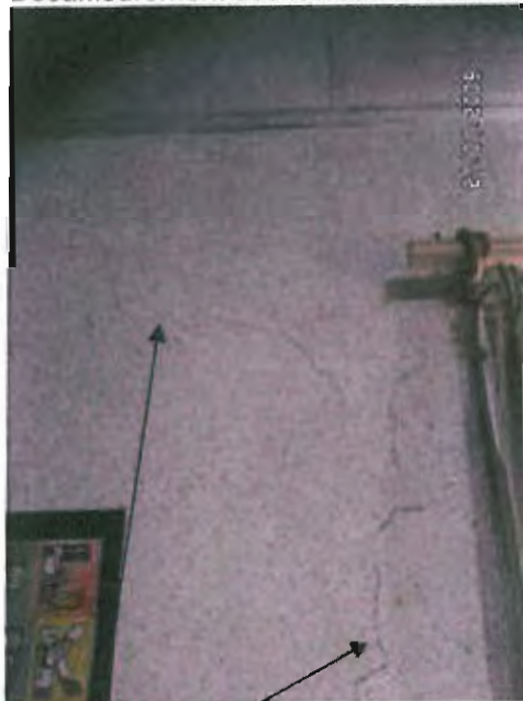
Début de la lézarde en haut du mur avec un départ horizontal
