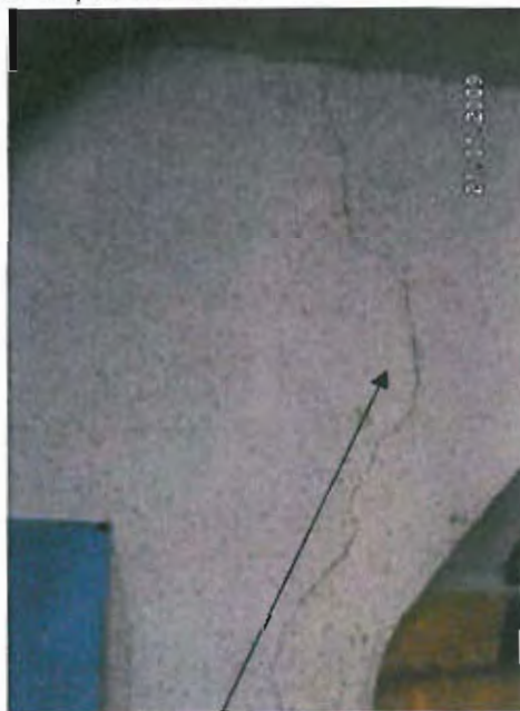
Début de la lézarde en haut du mur avec un départ horizontal
