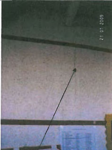
Fissure verticale dans le mur servant de séparation entre le couloir et les classes, au niveau de la pénétration des conduits.
