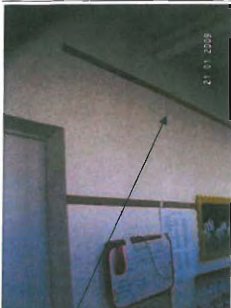
Fissure verticale dans le mur servant de séparation entre le couloir et les classes, au niveau de la pénétration des conduits.
