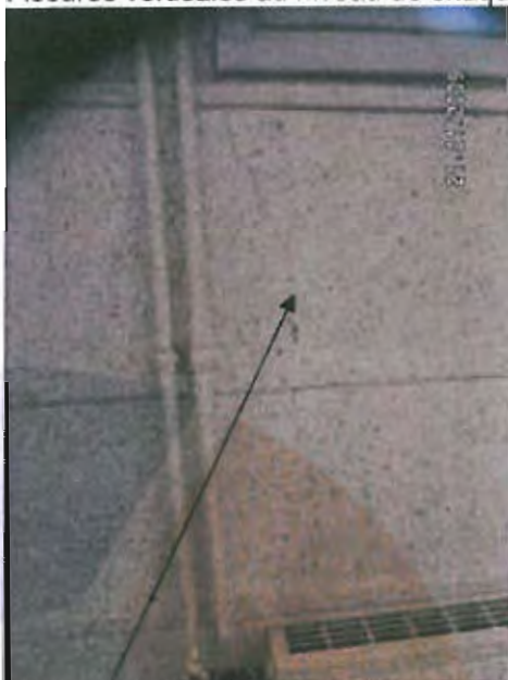
Fissures verticales au niveau de chaque poteau
