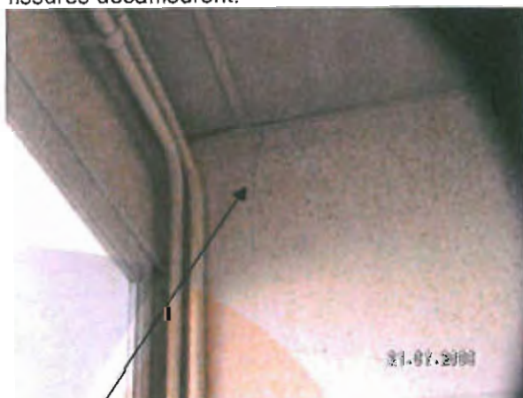
Fissure verticale traversante
