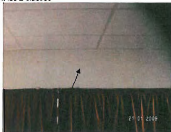
Fissure horizontale traversante sur le mur séparant les 2 classes
