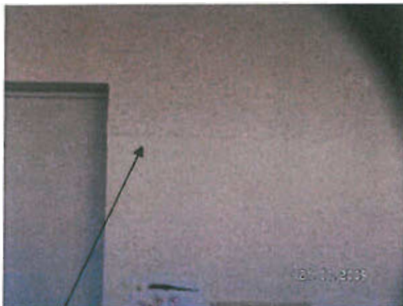
Au début du couloir dans le mur de séparation des classes et des locaux techniques, plusieurs fissures, une horizontale traversante en haut à droite de la porte, une en biais sur le mur de la porte et au coin de l'angle rentrant, une horizontale en pied de mur.
