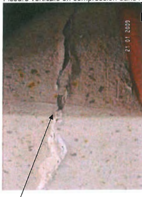
Fissure verticale en compression dans l'allège de la baie séparant les 2 classes
