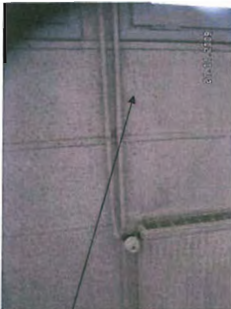
Fissures verticales au niveau de chaque poteau
