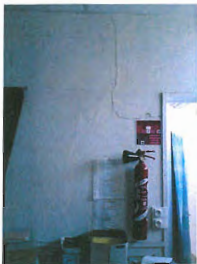
Pic 4 : élévation mur de refend côté porte
