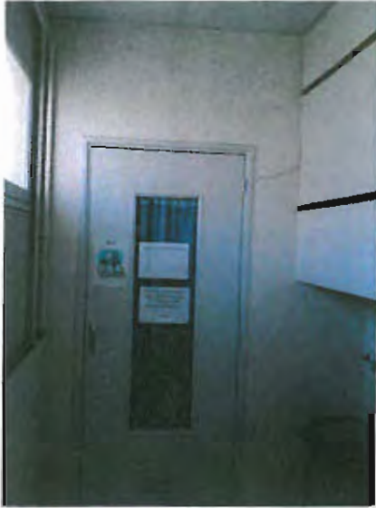
Pic 4 bis côté couloir
